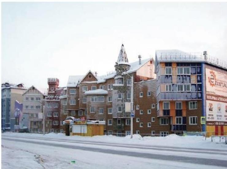
Рис. 1-1. Жилой дом по ул. Советской, 98: пример трансформации недостроенного панельного пятиэтажного здания
